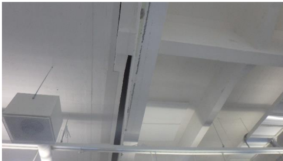
Välipohja vaihtuu kaksoislaattapalkistosta ylälaattapalkistoksi
