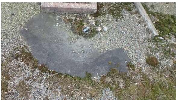
Sammalta kaivon ympärillä
