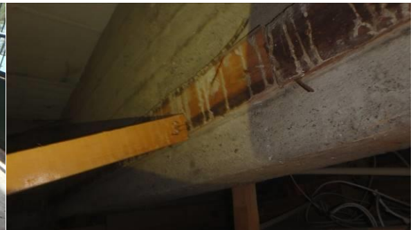
Vanhoja muottilaudoituksia käytetty kantamaan alaslaskettua kattoa
