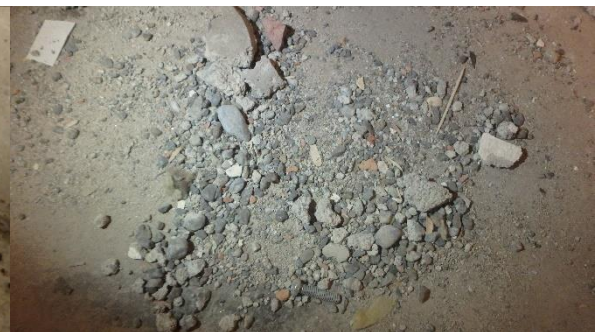
Välipohjan kiviainestäyttöä, puutikut, ruuvi ja villat olivat valmiiksi lattialla
