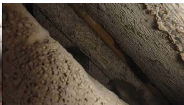
Räystäsrakennetta: betoniräystäessä aukko, josta näkyy Tojalevy ja lauta
