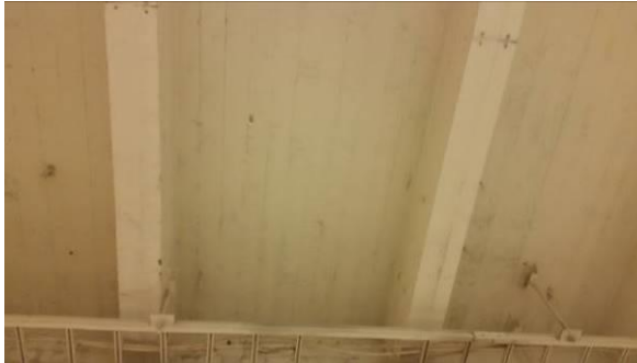
Yläpohjat ovat pääosin ylälaattapalkistoja
