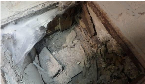
Rakennusjätettä ja muottilautoja luukussa
