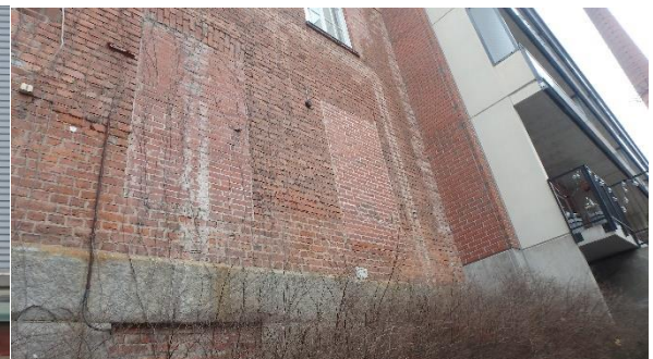
Aukkoja muurattu umpeen, rapautuneita tiiliä, sokkelissa kiverhous
