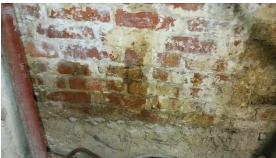
Öljyjäämiä maanvastaisen seinän tiiliverhouksessa ja betonissa
